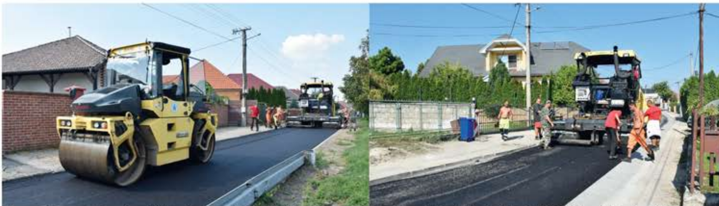
Koncom júla sa začala realizovať rekonštrukcia časti Mlynskej ulice. V rozpočte bolo vyčlenených na túto rekonštrukciu 180 000 eur. Bola vybraná firma, ktorej úlohou bolo túto rekonštrukciu realizovať, a následne bola podpísaná zmluva. Rekonštruovala sa časť od križovatky smerom na Chalupy až po koniec Mlynskej ulice. Práce trvali niekoľko týždňov, boli osadené obrubníky po oboch stranách a nanosený bol nový asfaltový koberec.
