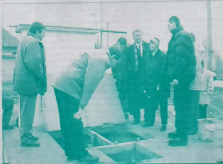
Zberná šachta kanalizácie
