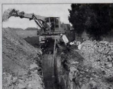
Výstavba kanalizácie v Močenku
