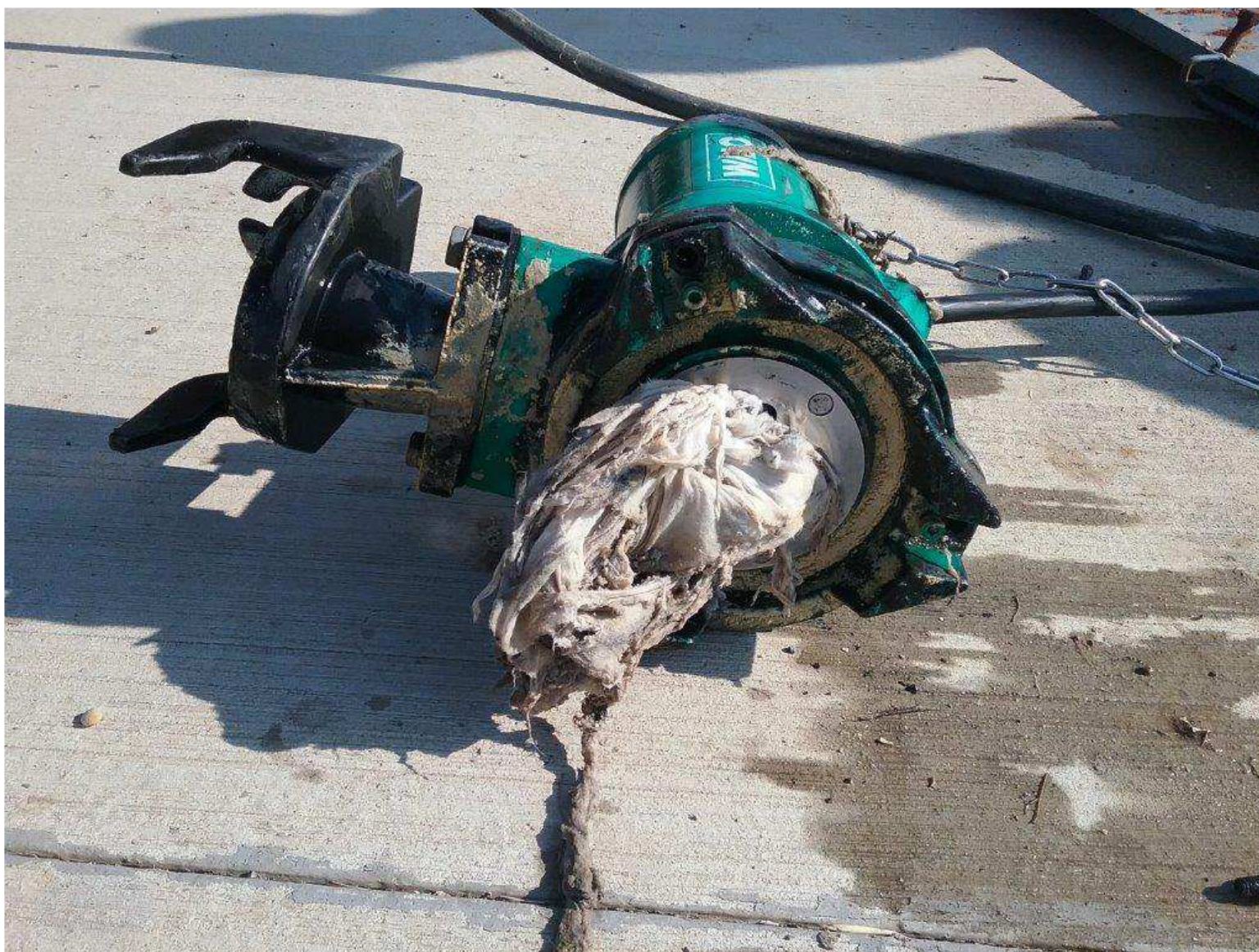
Upchané čerpadlo vlhčenými obrúskami
