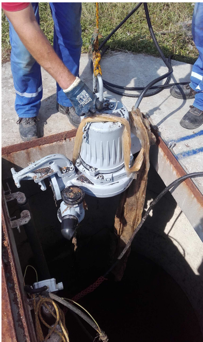
Odpad zachytený na čerpadle
