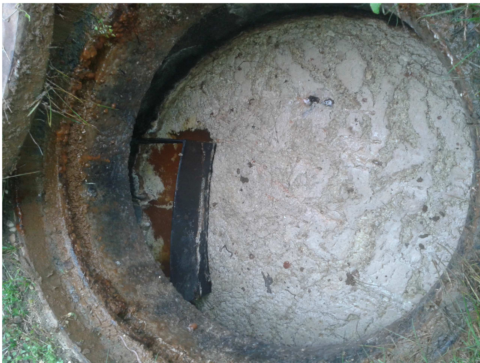
Tuky v upchanej kanalizácii
