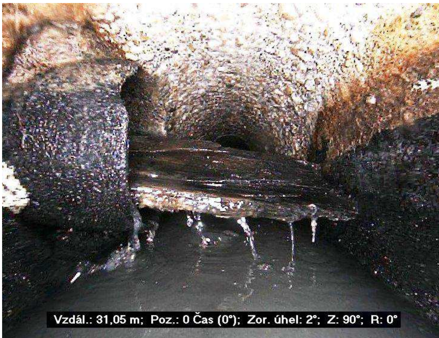
Drevo v kanalizácií
